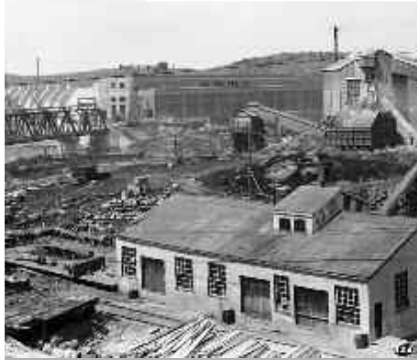
1925 / BAC (3517972) Construction de la centrale hydroélectrique d'Isle-Maligne
